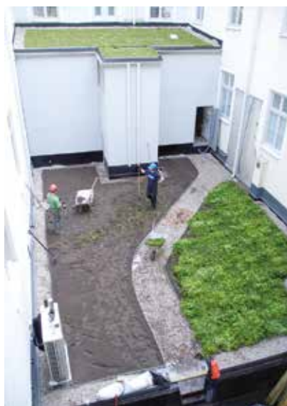
Kantstöden är smidiga att anlägga och går att böja till valfri form.
